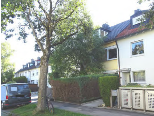
Nordwestseite des Reihenhauses
