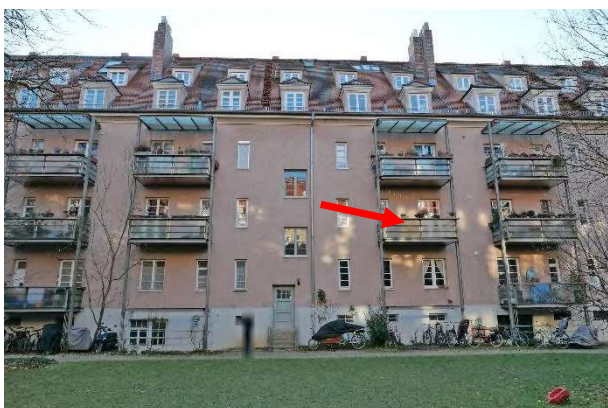
Ansicht von Nordnordwesten
