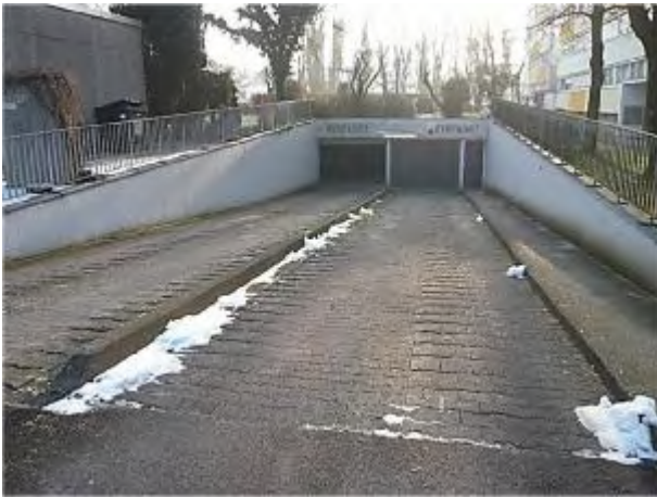
Tiefgaragenein-/ausfahrt v. Nordwesten
