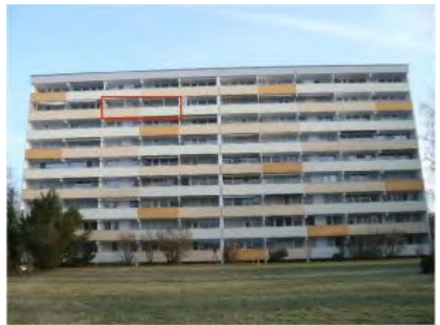
Gebäude Hs.Nrn. 1, 3 Ansicht v. Südwesten
