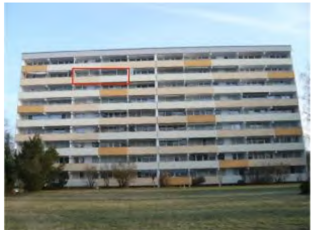
Ansicht v. Südwesten
