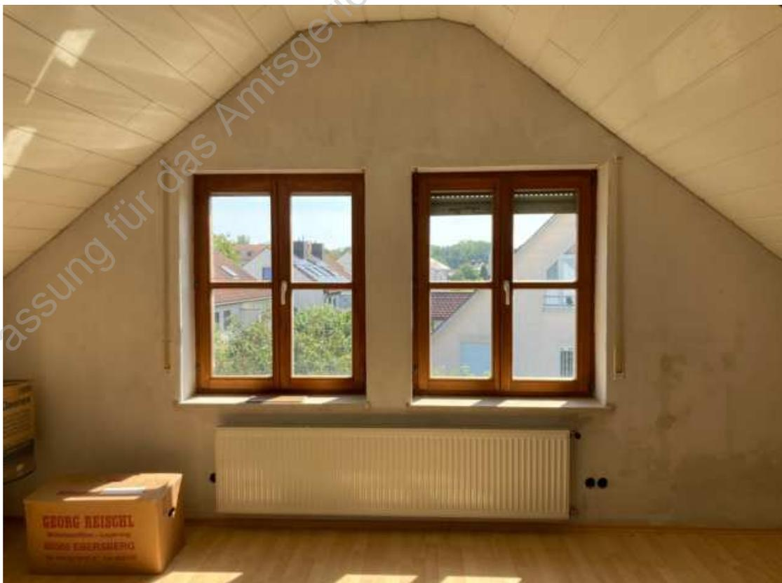
Foto 43: DG/unverputzte Giebelwand, fehlende Steckdosen
