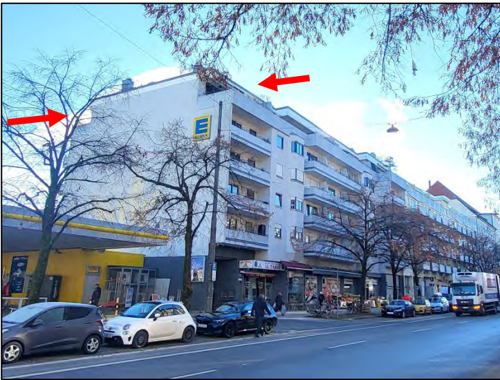
Die ETW Nr. 61 befindet sich im 5. OG (DG) des Wohn- und Geschäftshauses Implerstraße 23 (siehe Pfeile)
