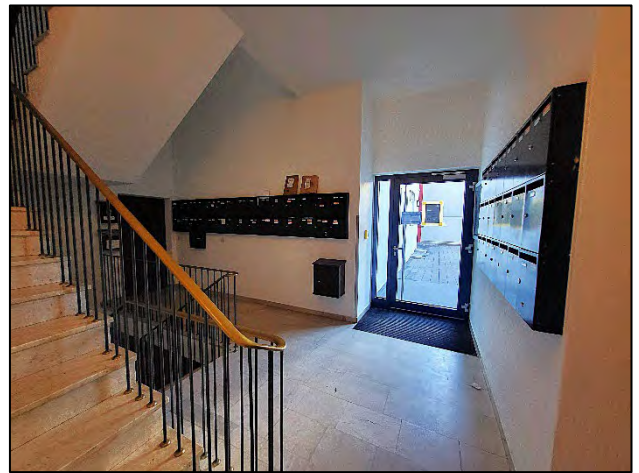
Foyer mit Briefkastenanlage; Blick in das Treppenhaus
