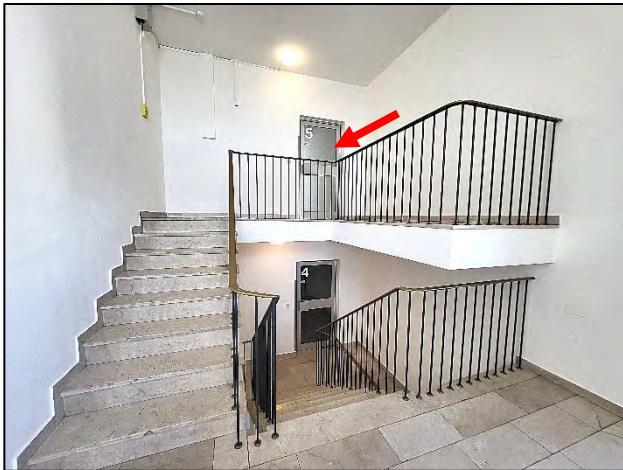
Blick auf den Treppenzugang zu dem Flur, der zur Eigentumswohnung Nr. 61 führt
