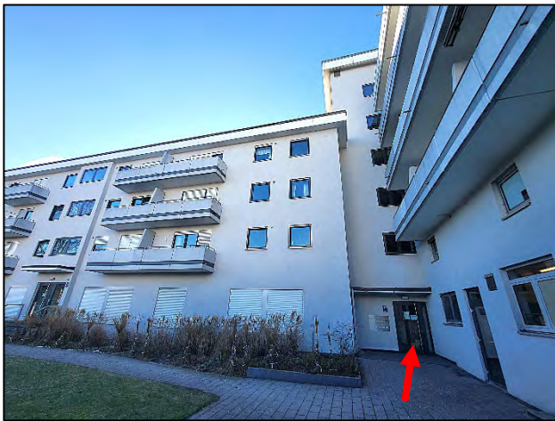
Blick auf den Hauseingang des Gebäudes Implerstraße 23
