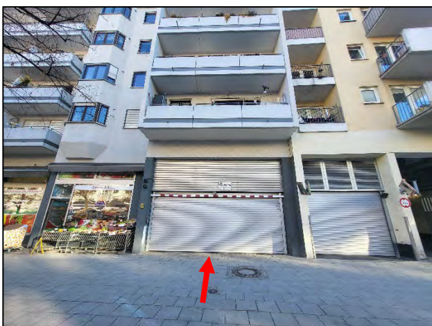
Tiefgaragenzufahrt an der Implerstraße; links Laden im EG
