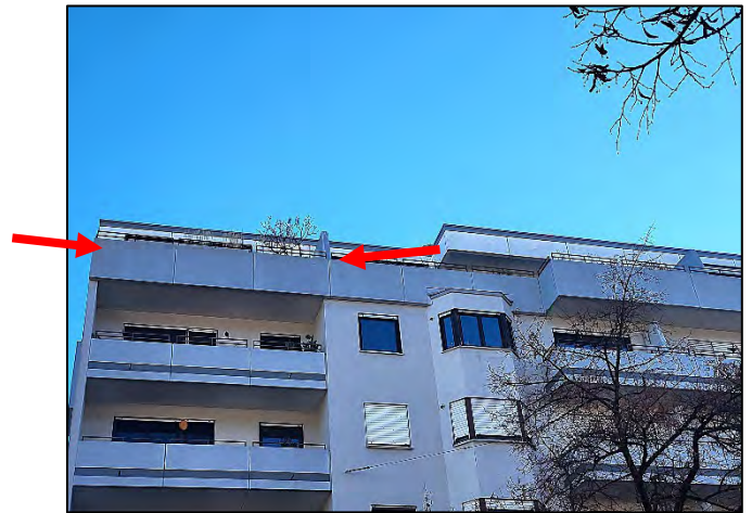
Die ETW Nr. 61 befindet sich im 5. OG (= DG) mit Dachterrassen zur West- und Ostseite
