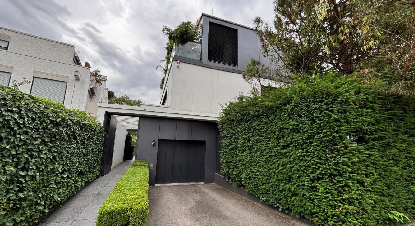
Blick auf das Einfamilienhaus mit Tiefgarage in Blickrichtung Westen
