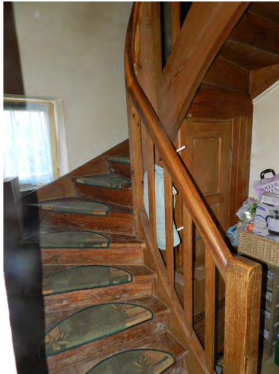
Treppe vom EG ins OG
