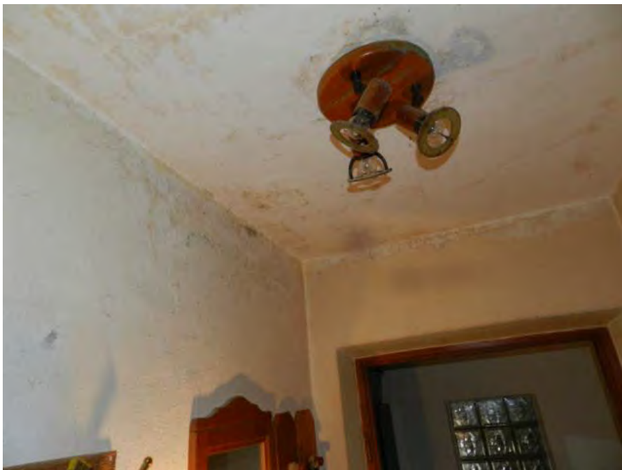
Decke im Flur, EG
