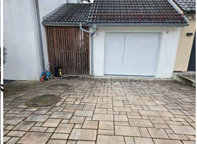
Garage mit Durchgang
