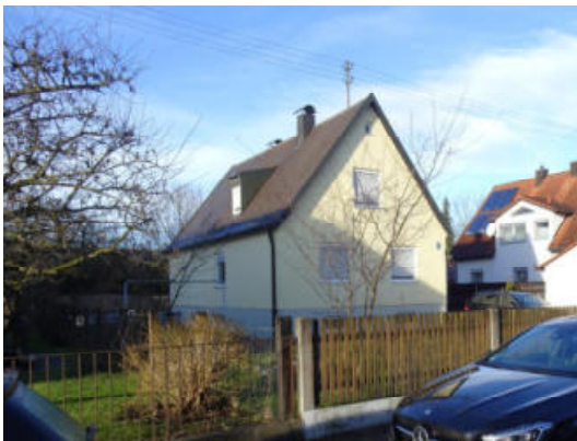
Süd- und Ostseite des Gebäudes
