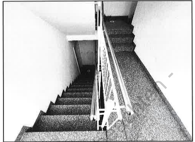
Blick in das Treppenhaus
