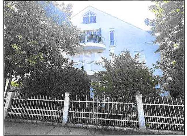
Blick von der Straße auf das Mehrfamilienhaus; westliche Giebelseite des Gebäudes
