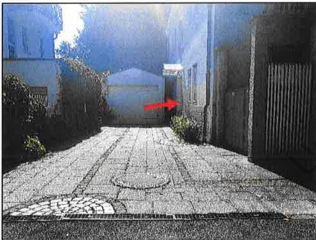
Eingangsbereich des Anwesens: hinten rechts Hauseingangstür (s. Pfeil); geradeaus TG-Zufahrt
