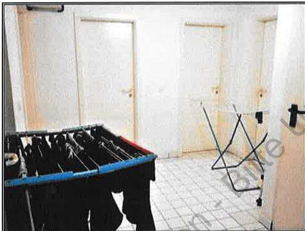
Abgemauerte Kellerräume für die Wohnungen Nr. 4, 5 und 6 im OG und DG
