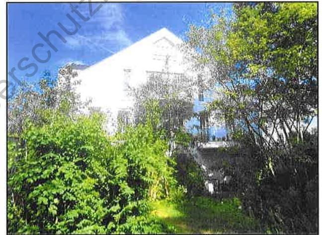
Blick vom Garten auf die Gebäuderückseite; östliche Giebelseite
