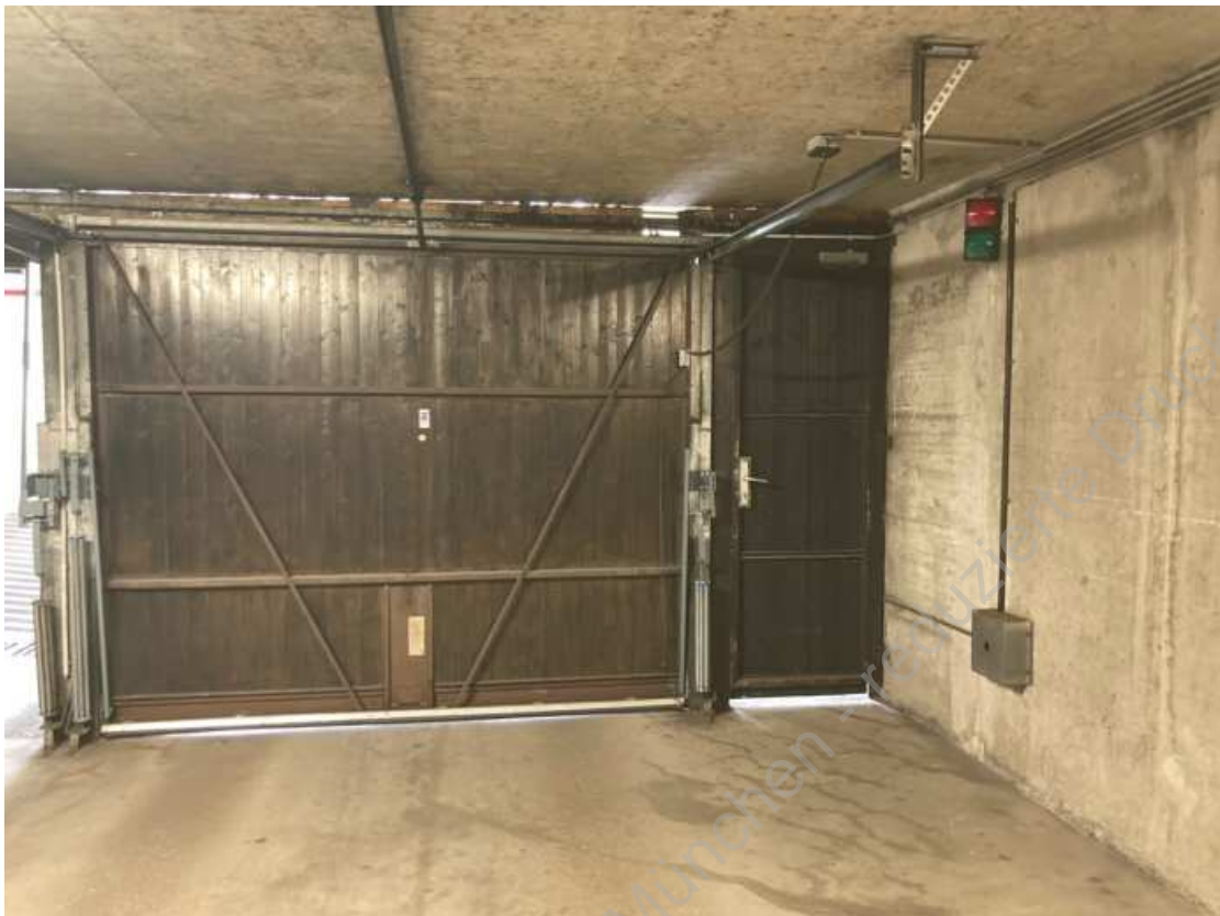
Foto 3: Ausfahrtstor mit seitlichem Ausgang
