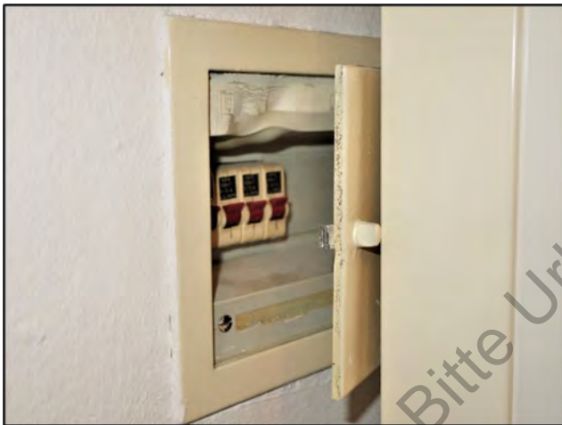
Sicherungskasten noch aus dem Baujahr
