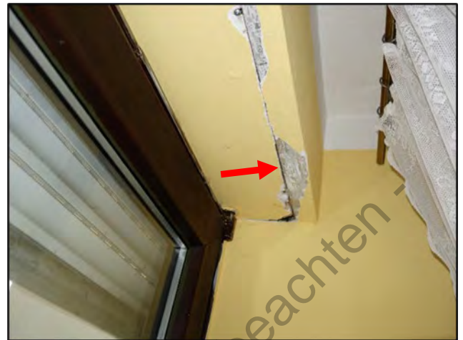
Rollladenkasten renovierungsbedürftig; der bauliche Zustand hatte sich – Angabe gemäß – nicht verändert
