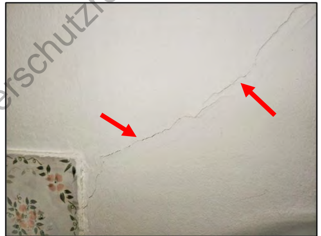
Leichte Rissbildung an der Zwischenwand der Küche zum Badezimmer
