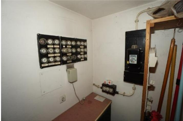
Elektro-Unterverteiler im Keller mit Schmelzsicherungen
