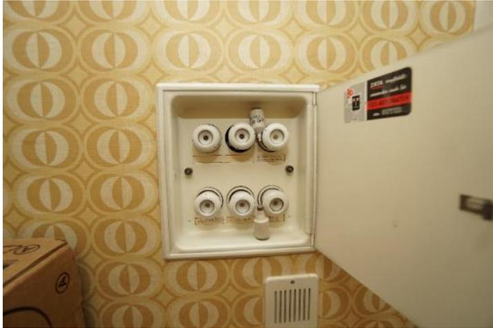
Unterverteiler mit Schmelzsicherungen
