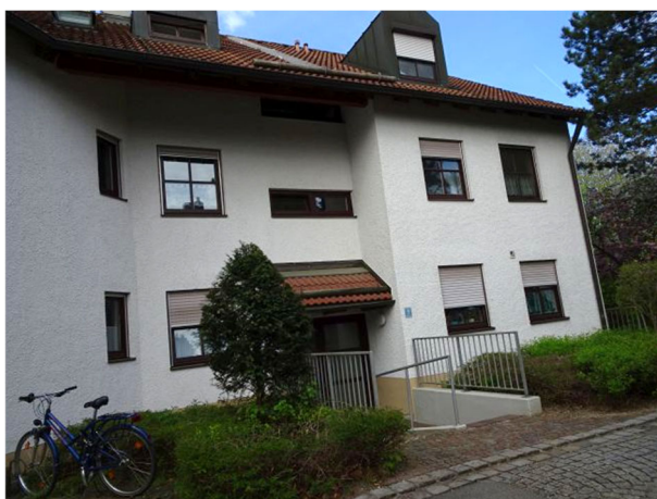
Hauseingang An der Biberwiese
