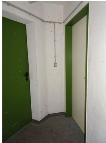
Keller, Zugang zum Kellerabteil
