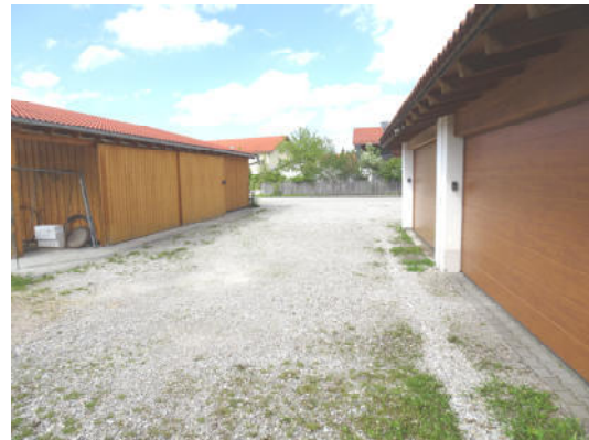
Garagenhof (u.a. Flst. 80/97) – Blickrichtung Nordost
