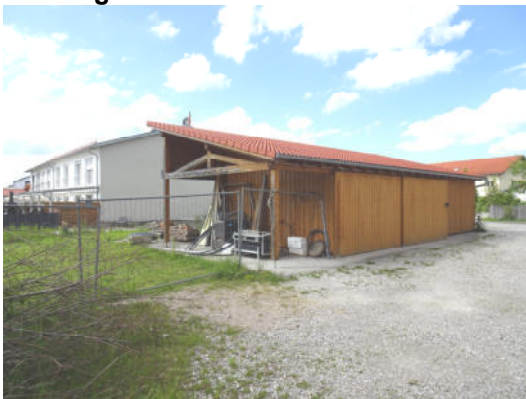
Garagegebäude – Blickrichtung Nordwest
