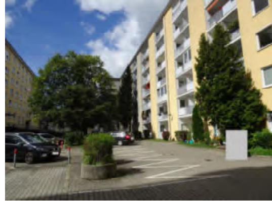
Hoffläche südlicher Grundstücksbereich
