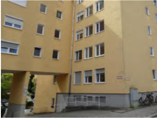
Hofzufahrt – Blickrichtung Südwest
