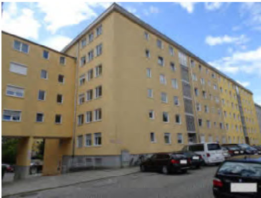
Nord- und Ostseite des Gebäudes
