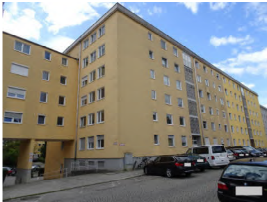
Nord- und Ostseite des Gebäudes
