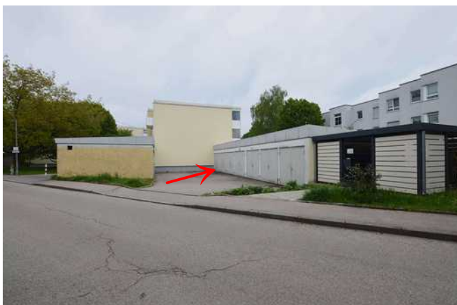
Garagenhof an der Hans-Holbein-Straße
