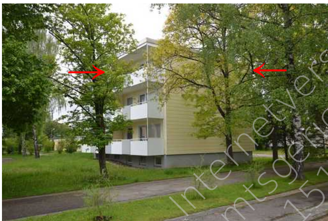
Ansicht von Südost
