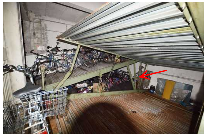
hinten: Duplexanlage in Garage Nr. 195
