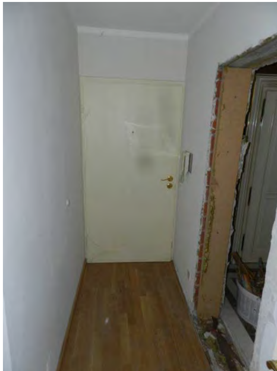
Whg. Nr. 11, Flur; rechts Durchbruch zur Whg. Nr. 10
