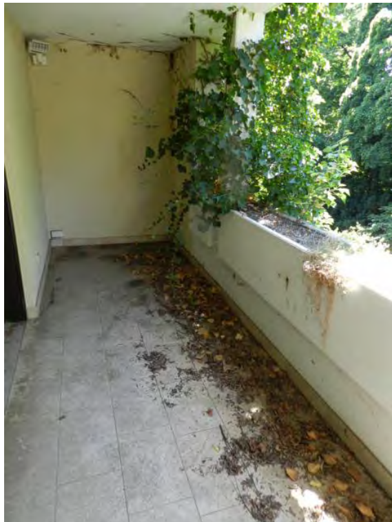
Whg. Nr. 10, Loggia 2. OG
