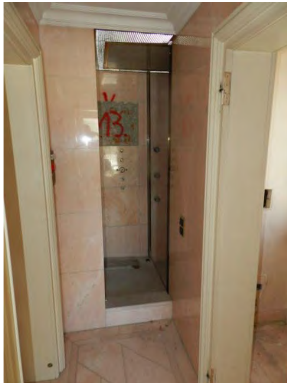
Whg. Nr. 10, Sanitärbereich 3. OG
