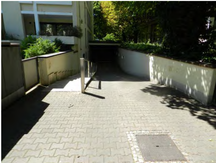
Zugang zum Hauseingang; Zufahrt zur Tiefgarage;
