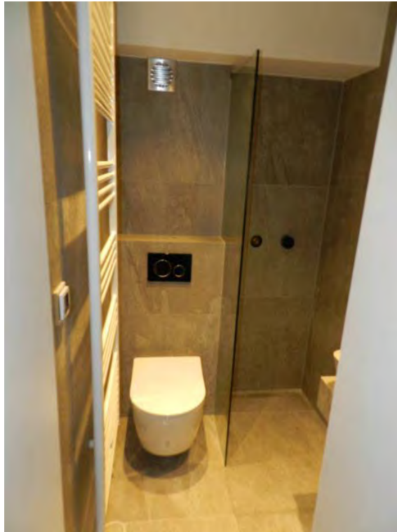
Duschbad Nr. 11, bei Kellerraum
