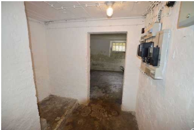
Zugang zu den Kellern auf der Südseite
