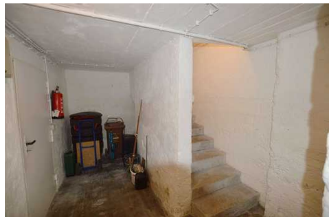
Flur mit Kellertreppe zum EG
