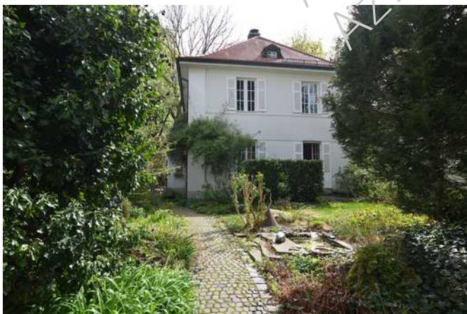
Haus Merzstr. 6, Ansicht von Westen
