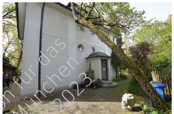
Ansicht Nordseite mit Hauseingang
