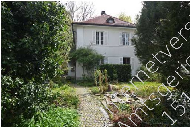
Haus Merzstr. 6, Ansicht von Westen
