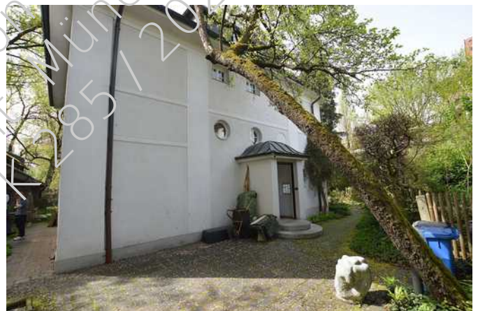
Ansicht Nordseite mit Hauseingang
