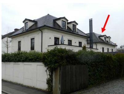
Ansicht von Südost
