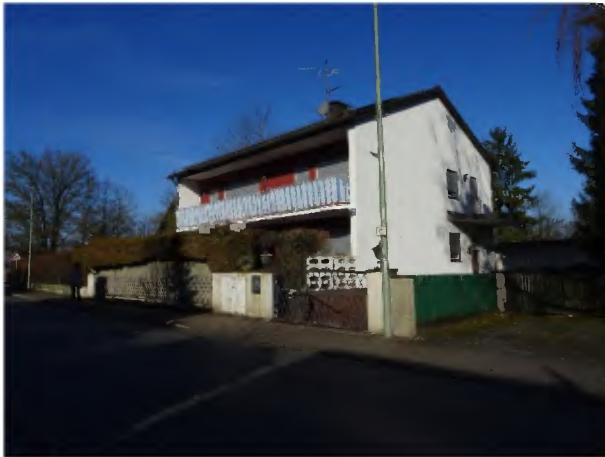
Südansicht von der Eichenauer Straße
