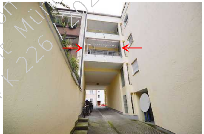
Ansicht von Westen (von der TG-Rampe)
