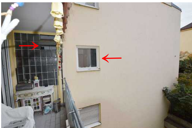
Balkon Whg. 11, Pfeile = nebenlieg. Fenster
