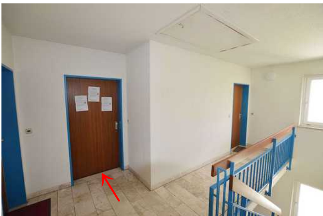
Treppenhaus 4. OG, Tür zu Whg. Nr. 191
