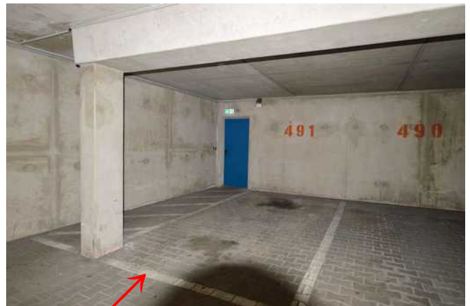
Tiefgarage, Stellplatz Nr. 491
