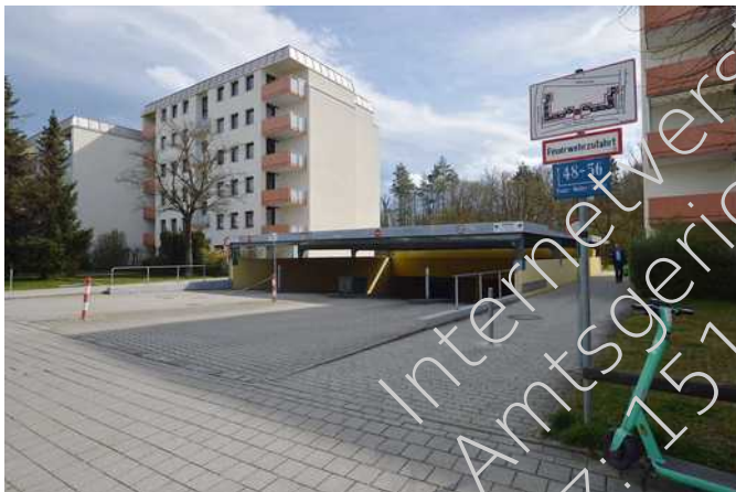
Zugang zur Gesamtanlage, mitte: TG-Zufahrt
