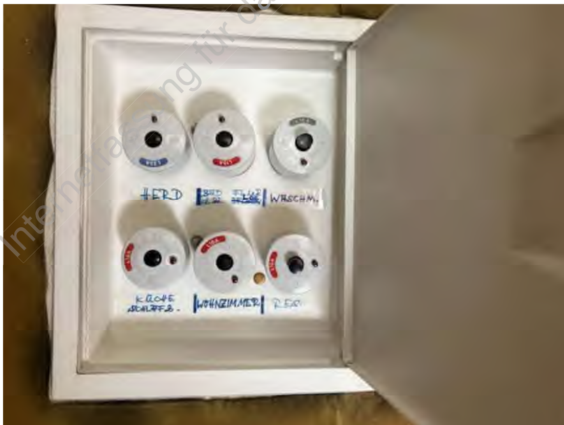
Foto 19: Unterverteiler
