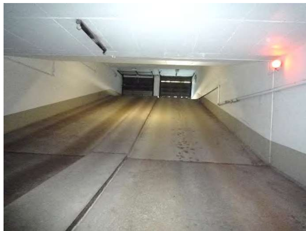
Tiefgarage Ein-/Ausfahrt KG
