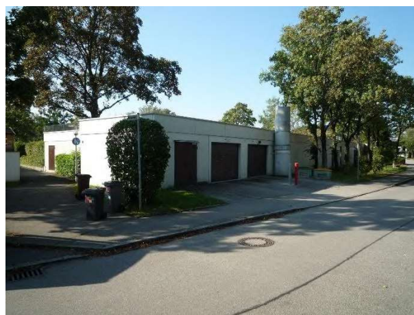
Tiefgarage von Nordosten
