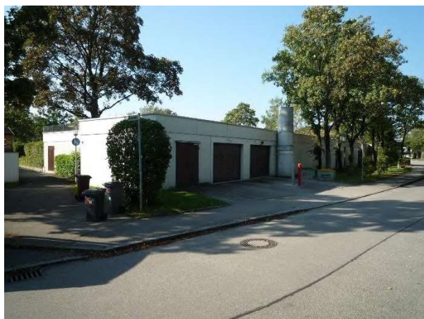
Tiefgarage von Nordosten
