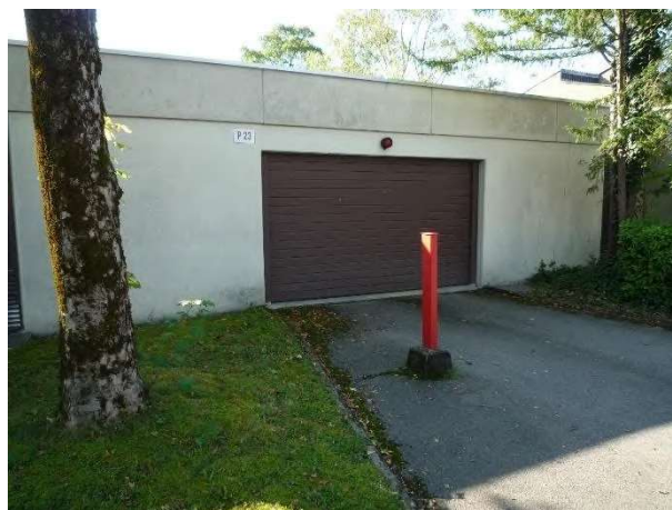
Tiefgaragenzufahrt EG von Norden
