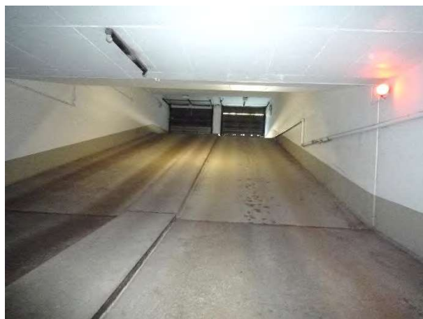
Tiefgarage Ein-/Ausfahrt KG
