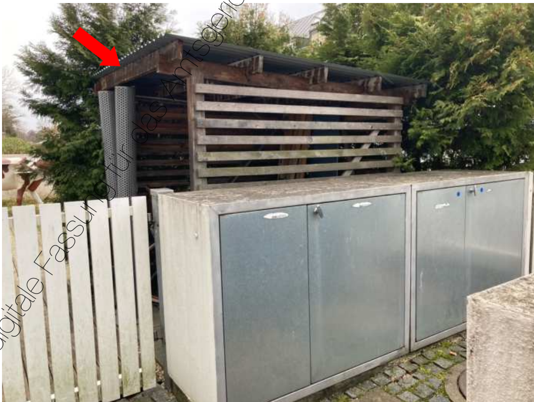
Foto 10: Unterstellplatz der Wohnung Nr. 1
