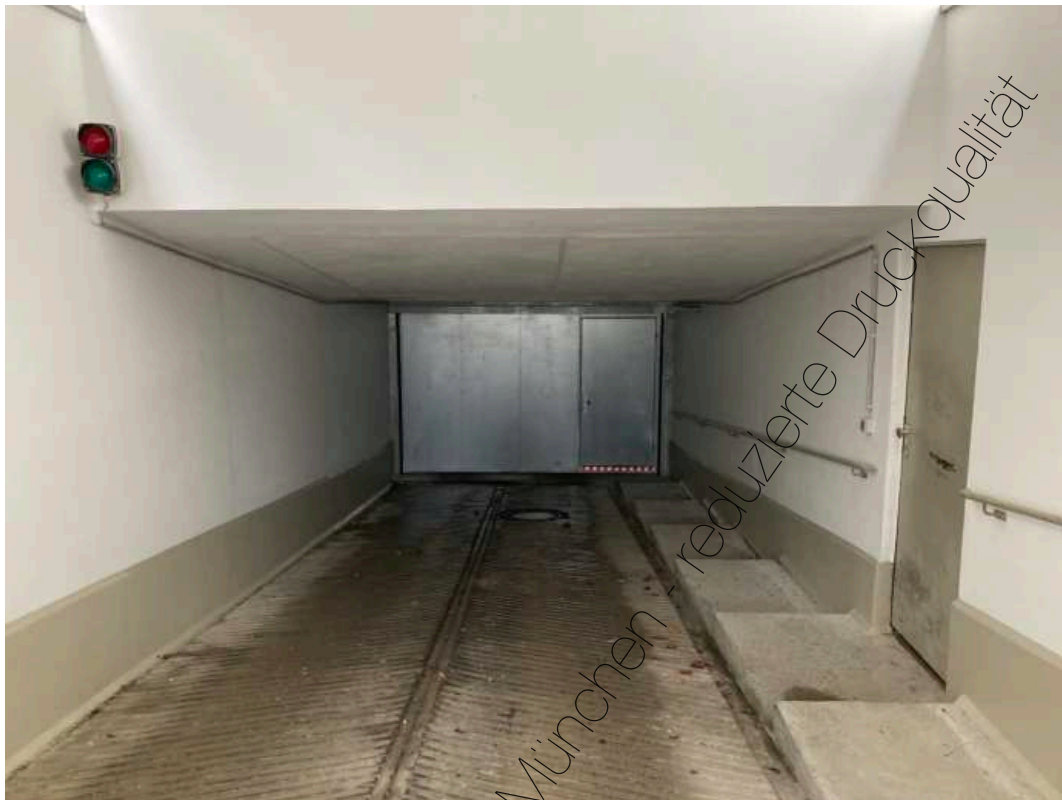
Foto 16: Zufahrt zur Tiefgarage
