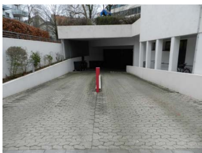
Tiefgarage Ein-/Ausfahrt, von der Ismaninger Straße
