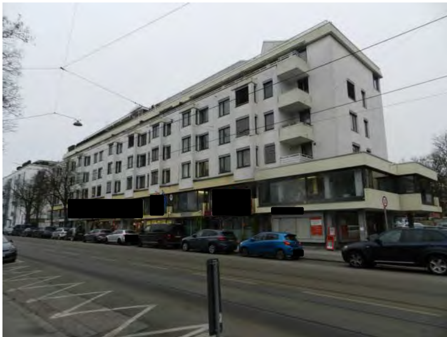
Ansicht von Westen, von der Ismaninger Straße
