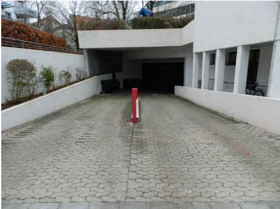
Tiefgarage Ein-/Ausfahrt, von der Ismaninger Straße
