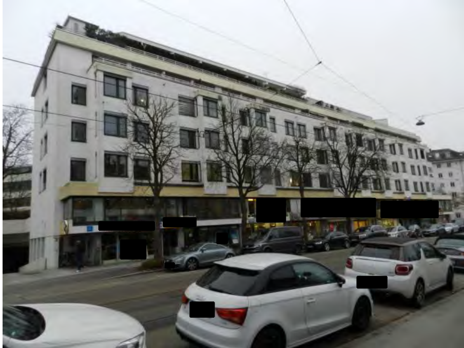
Ansicht von Nordwest, von der Ismaninger Straße
