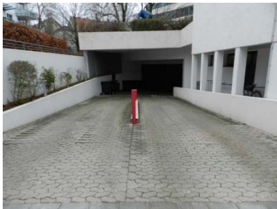
Tiefgarage Ein-/Ausfahrt, von der Ismaninger Straße
