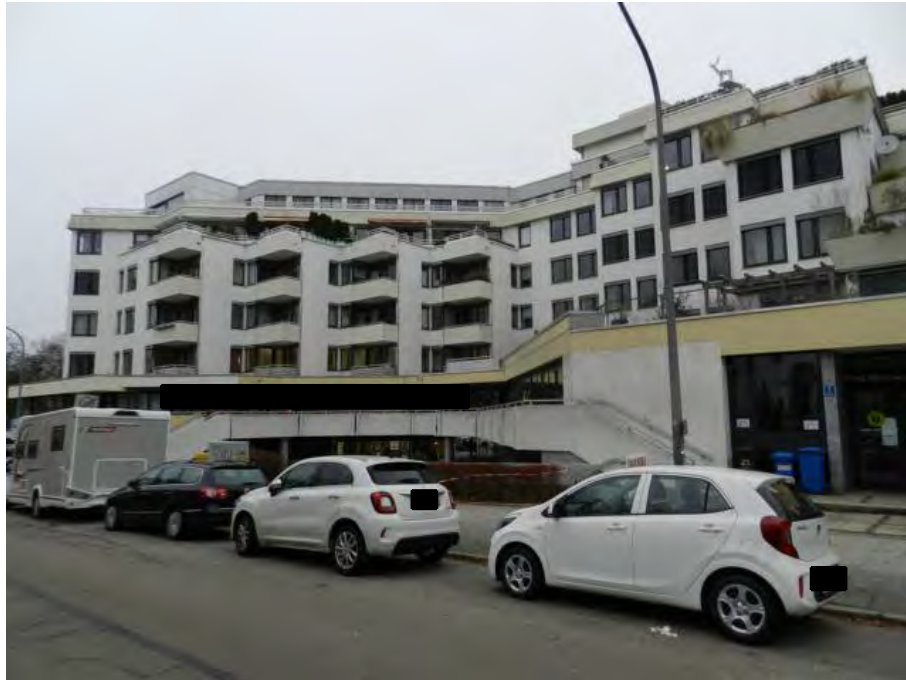
Ansicht von Süden, von der Wehrlestraße
