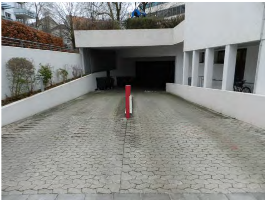
Tiefgarage Ein-/Ausfahrt, von der Ismaninger Straße
