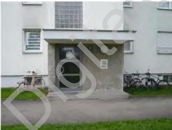
Hauseingang v. Nordosten
