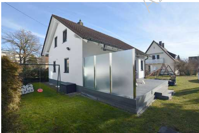
Ansicht von Westen (am 30.01.2024)
