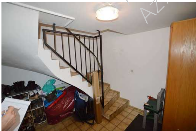
Kellerflur mit Treppe zum EG
