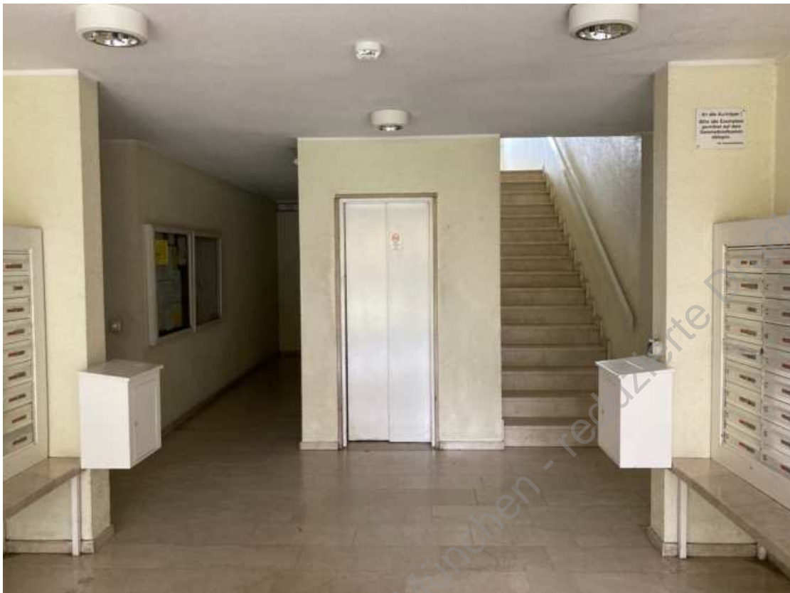
Foto 9: Treppenhaus und Aufzug
