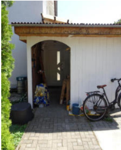
Vorgarten Westseite mit Hauszugang
