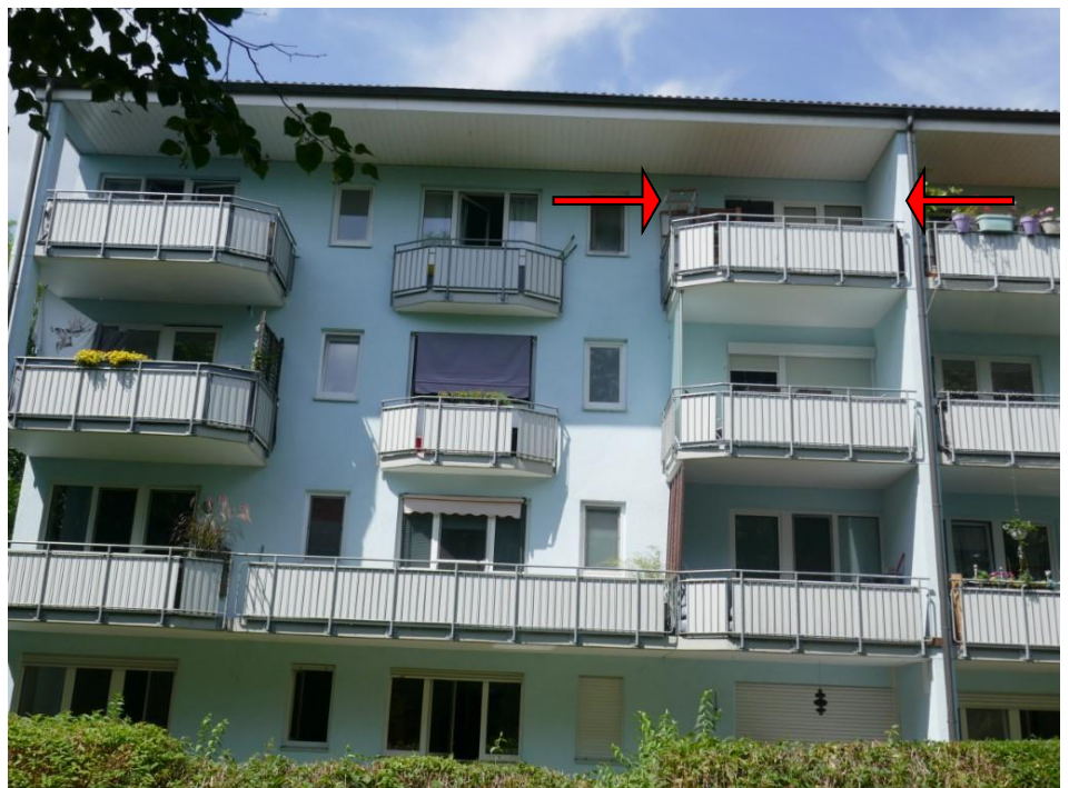
Blick auf die gartenseitige Ostfassade
