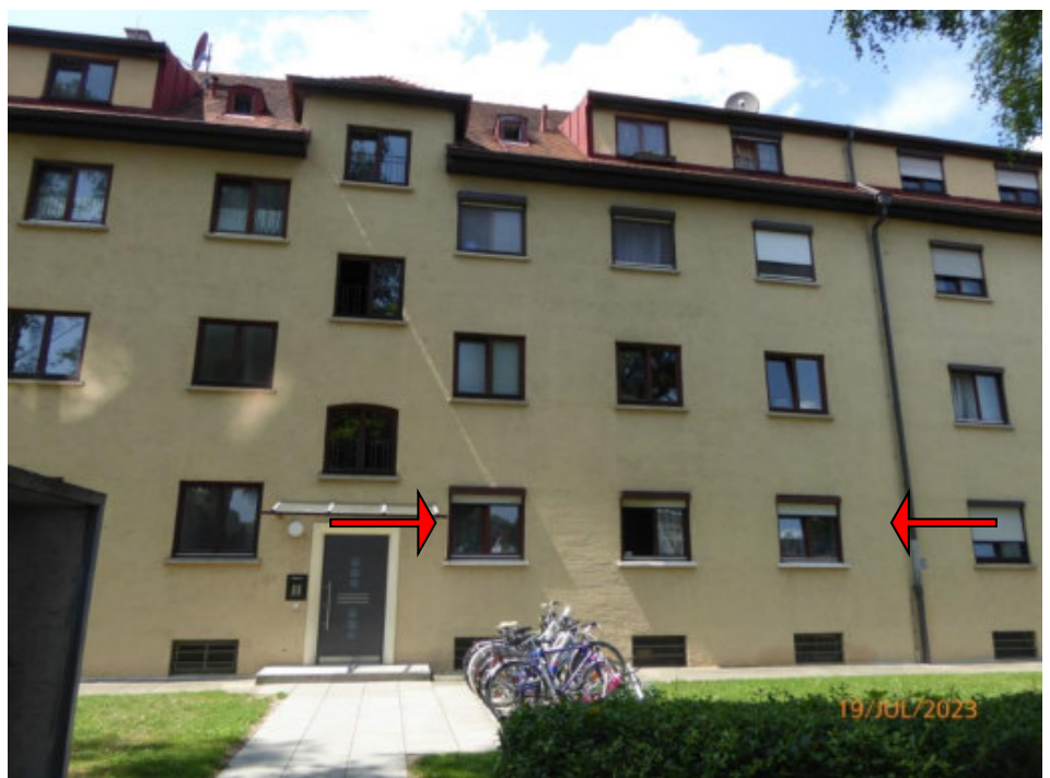
Blick von der Nordenstraße auf das Gebäude Nordenstraße 4 mit der Wohnung Nr. 14
