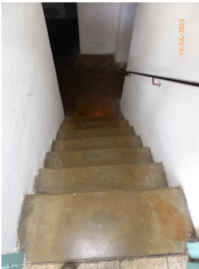
Blick auf die Treppe in das Kellergeschoss
