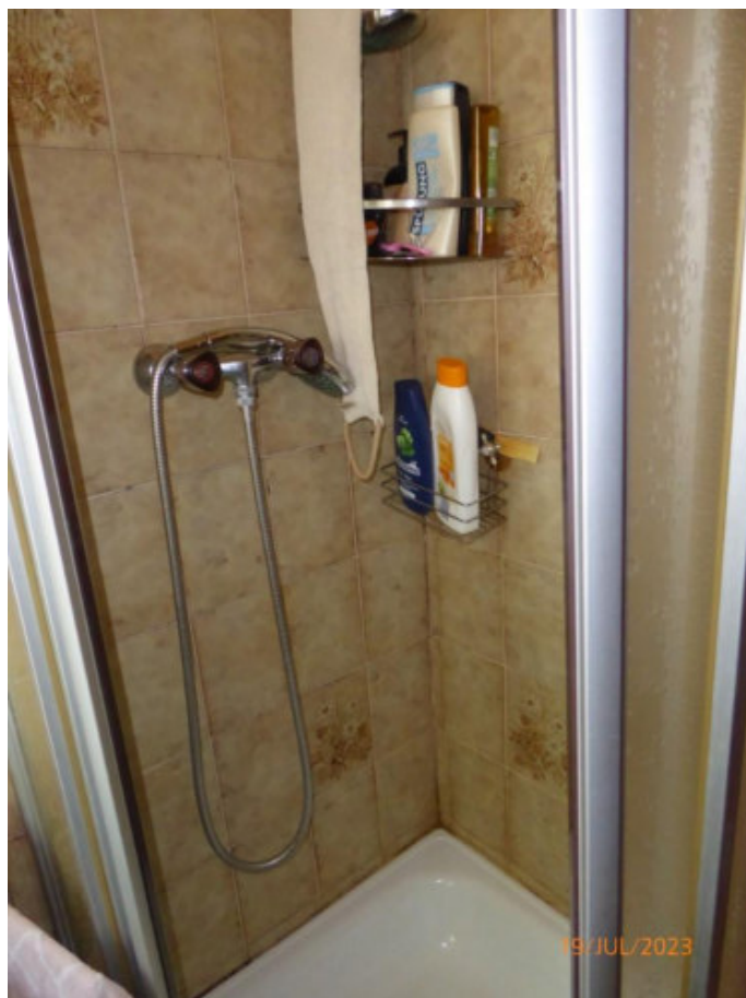
Blick in die Dusche
