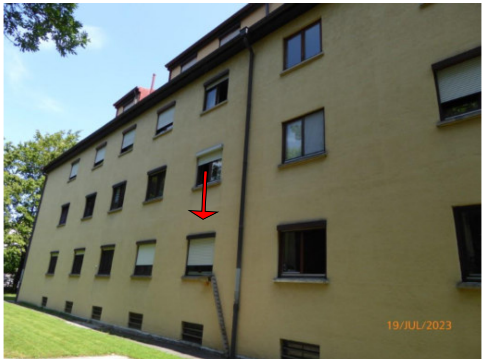
Blick auf die rückwärtige Fassade mit dem Fenster des Zimmers 2 der Wohnung Nr. 14
