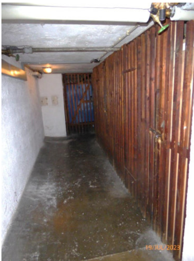
Blick in den Kellerflur
