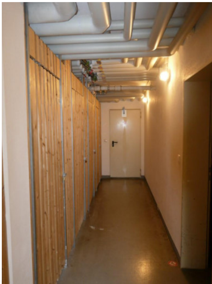
Blick in den Kellerflur
