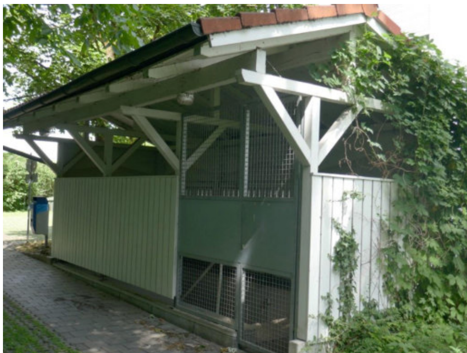
Blick auf das rückwärtige Gebäude des Tiefgaragen-Notausgangs
