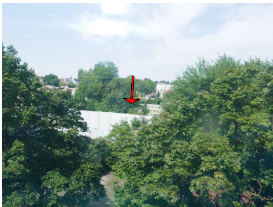
Blick vom Wintergarten in westlicher Richtung auf das Bahngelände mit der Schallschutzwand
