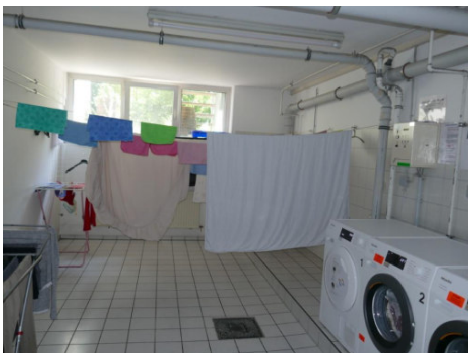
Blick in den Wasch- und Trockenraum
