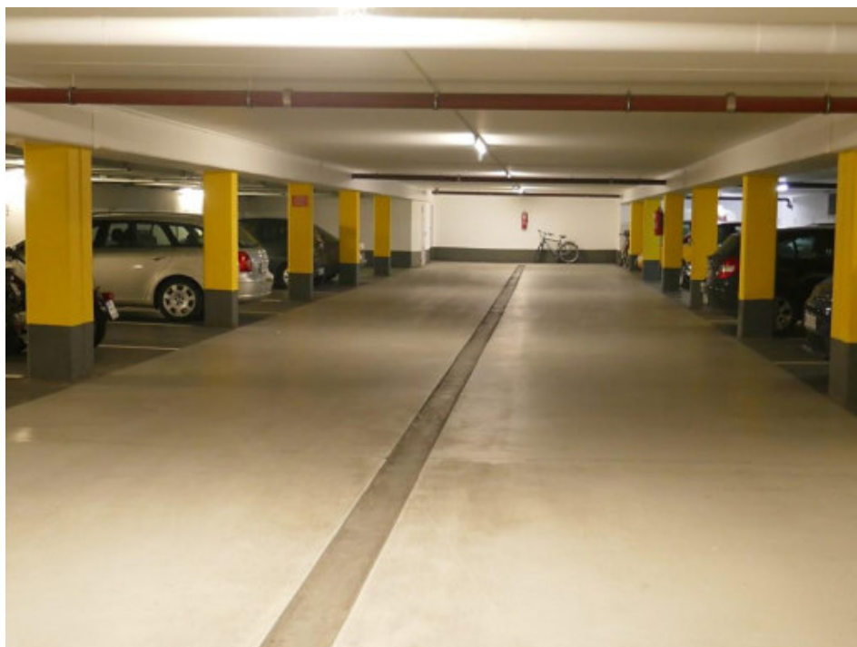
Blick in die Tiefgarage
