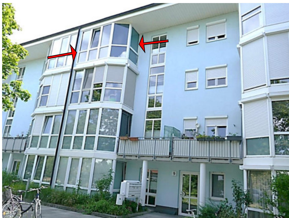
Blick auf die zugangsseitige Westfassade
