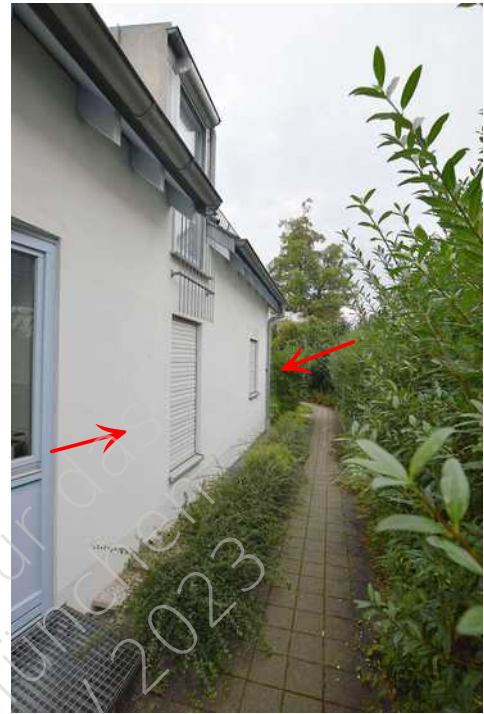
Weg auf der Nordseite des Rückgebäudes, links: Whg. Nr. 8 (Schlafzimmer und Bad)
