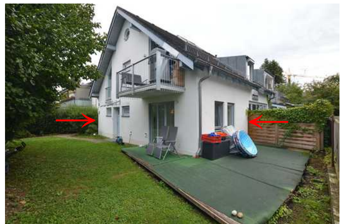
Ansicht Rückgebäude von Südwesten, Whg. Nr. 8 im EG, davor SoNu-Fl. SNR8
