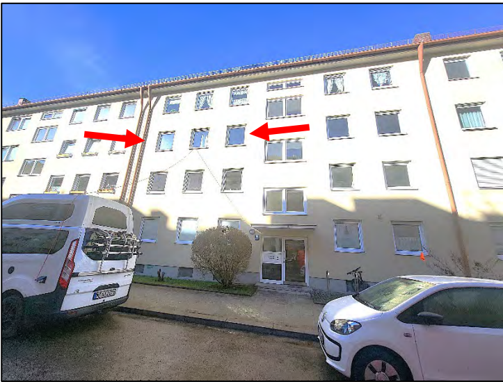
Blick auf das Mehrfamilienhaus Schanzenbachstraße 10; die ge- genständliche ETW Nr. 66 befin- det sich im 2. OG (siehe Pfeile)
