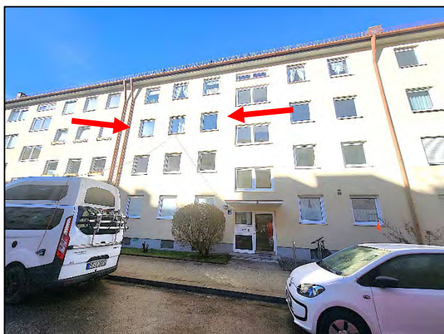
Vorderansicht des Gebäudes mit Hauseingang; Lage ETW Nr. 66 im 2. OG (siehe Pfeile)
