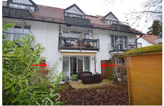
Haus Feichtstr. 3, Ansicht Südseite (Gartenseite)
