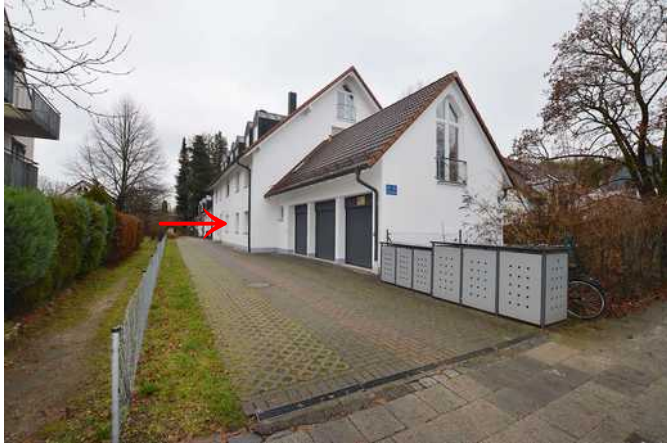
Weg Flst. 1435/10 von der Feichtstraße, mit Zugang zu den Häusern Nr. 3, 3a - 3c, 5
