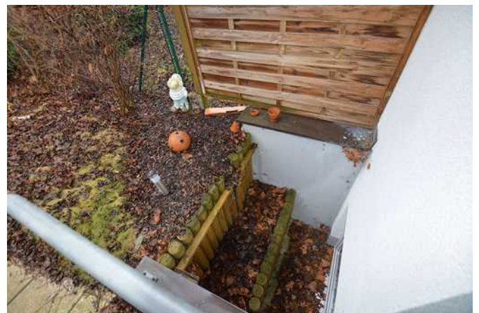
Abböschung zur Belichtung des Hobbyraums im Keller Wohnung Nr. 2
