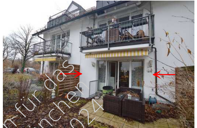
Ansicht Südseite mit west. Nachbarhaus
