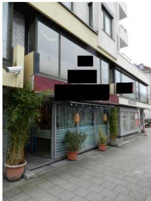
Ansicht Teileigentum Nr. 50 (EG/OG) in der Nordwestfassade
