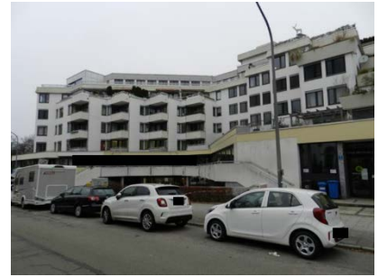
Ansicht von Süden, von der Wehrlestraße
