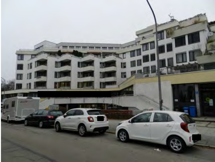
Ansicht von Süden, von der Wehrlestraße
