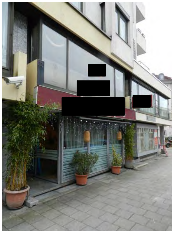
Ansicht Teileigentum Nr. 50 (EG/OG) in der Nordwestfassade
